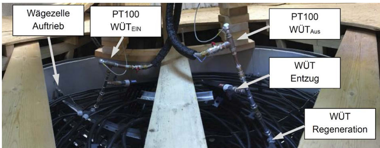
Abbildung 2-132: Speicherinnenraum mit angehobenem Speicherdeckel und Sensoren (WÜT: Wärmeübertrager)
