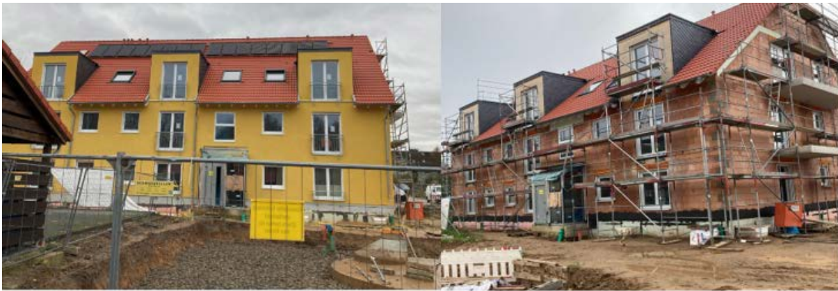
Abbildung 4-35: Neubau eines der drei Mehrfamilienhäuser der Anlage 4
