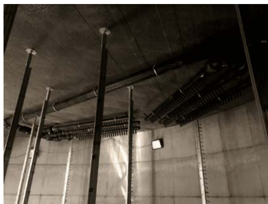
Abbildung 4-19: Eisspeicher – vorbereitet für den Einbau der Wärmeübertrager (im Bau)
