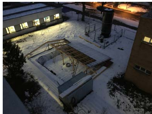
Abbildung 2-130: Einbringung des Laborspeichers am Außenlabors am IGTE und Aufbau einer Überdachung.
