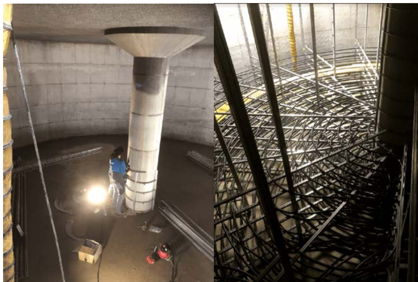
Abbildung 4-18: Stahlbeton-Rundbehälter bzw. Eisspeicher (im Bau)
