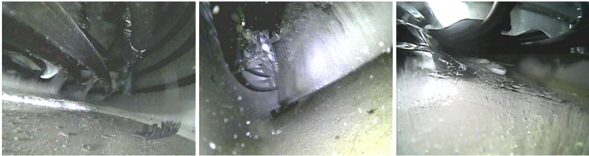
Abbildung 2-166: links: Eisformation in Bodennähe bei 1. Regeneration; Mitte: Eisformation in Bodennähe bei 2. Regeneration; rechts: Eisformation in Bodennähe bei 3. Regeneration – zu sehen ist hier eine Eisplatte zwischen der untersten Ebene der Rohre des Entzugswärmeübertragers und dem Boden.
