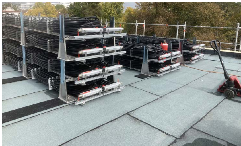
Abbildung 4-17:Zweilagige Montage der Kollektoren des Typen SLK-600
