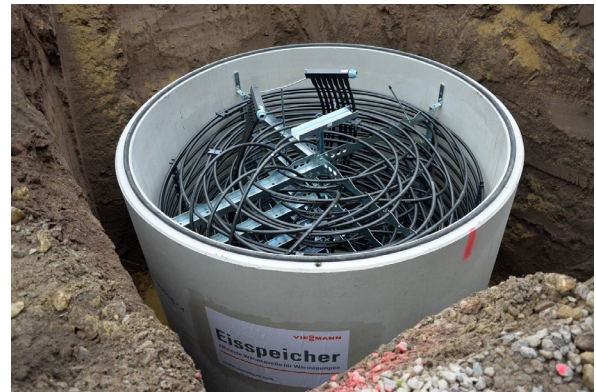
Bild: Eisspeicherbauart Stand der Technik.
