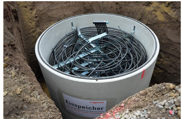
Bild: Eisspeicherbauart Stand der Technik.
