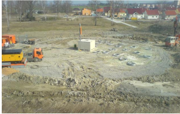
Abb. 8: Blick auf die Baustelle des ESWSP
