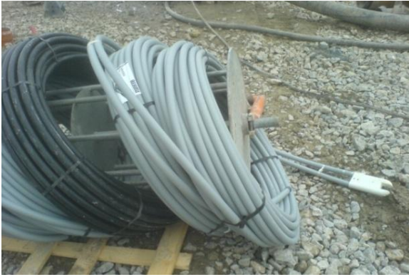
Abb. 7: Rollen mit PE-Xa Erdwärmesonden
